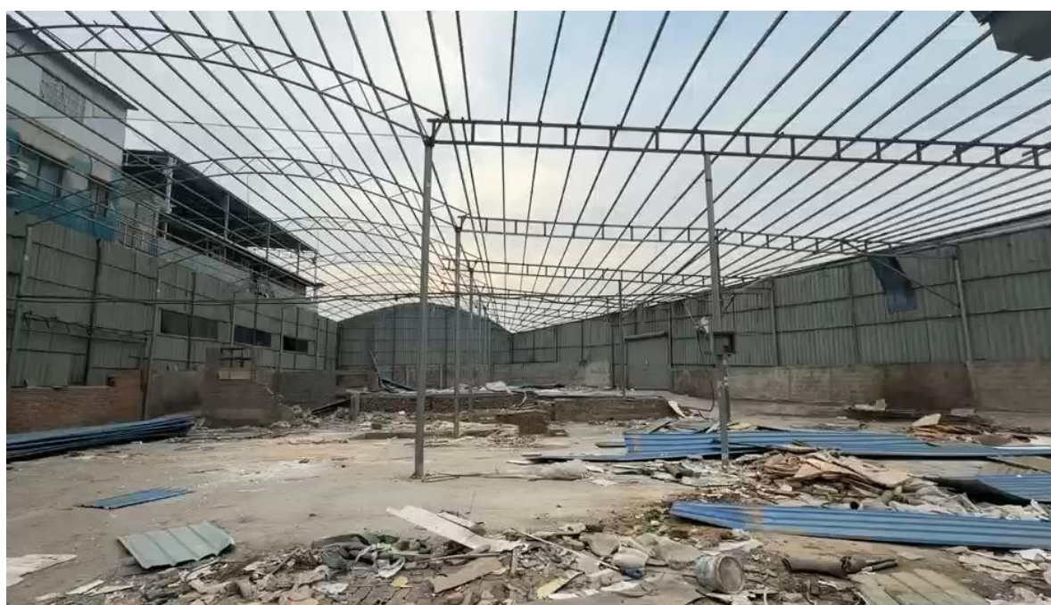
厂房内部现状图
