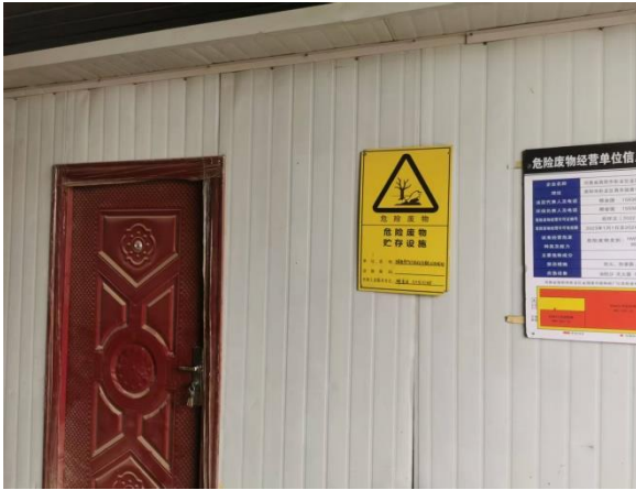
图1 破损电池仓库
